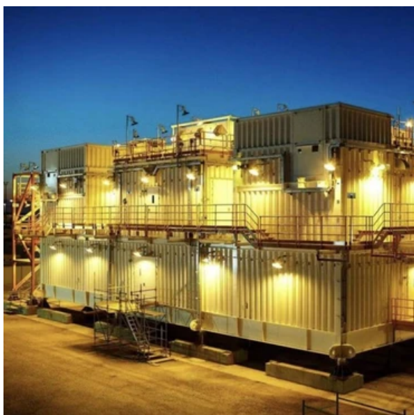
Un edificio modulare della Tozzi Group
